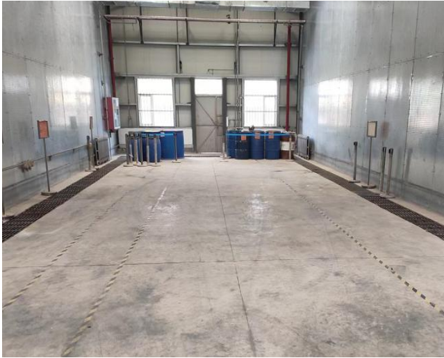
(3) 危废暂存间内部
